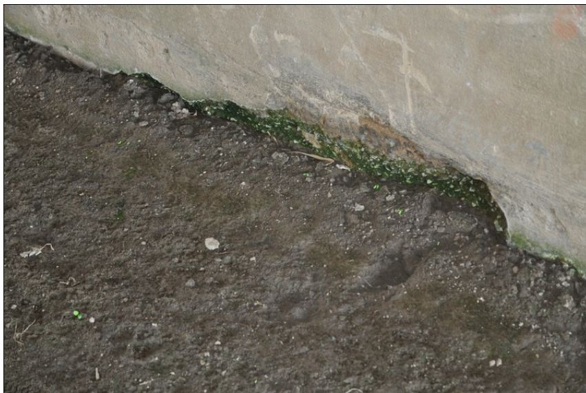
Odmrzání prostého betonu opěry 2.
