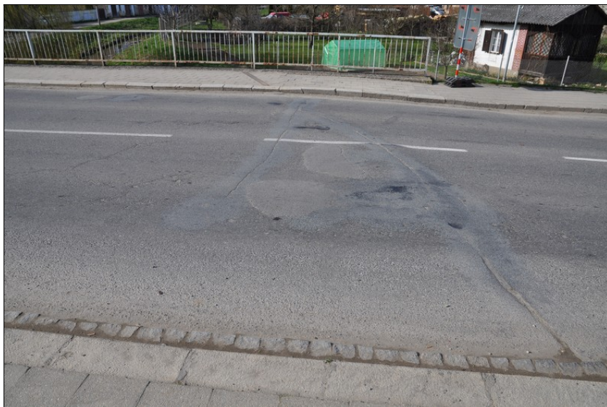
Spára ve vozovce nad závěrem.
