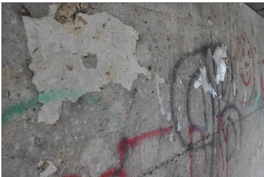
Líce opěr jsou napočokovány.
