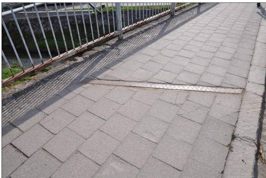
Překrytí dilatace vpravo nad opěrou 2.
